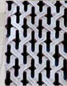
Celosías en la Iglesia de San Miguel, Zaragoza. (José María Sorando)
