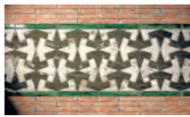
Ambulante en un muro de la Alhambra.
